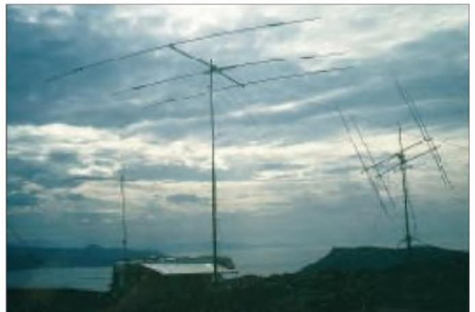
**Take-Off in 200 m ü. NN nach Mitteleuropa: links die 17-Ele.-M<sup>2</sup>, in der Mitte der 3-Ele.-Beam, rechts die EME-Antennen.**
