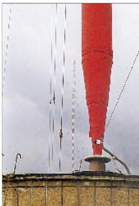
Gegen Erde isolierter Mastfuß eines 216-m-Vertikalstrahlers mit Funkenstrecke und Speiseleitung, im Hintergrund der 325-m-Mast
