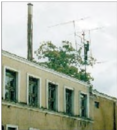
Antennenarbeiten bei YO5KAI in KN16TS
