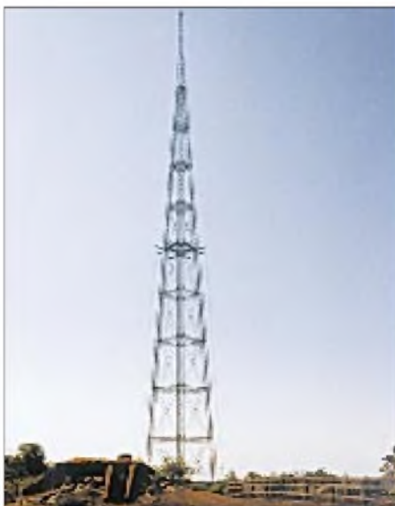
Einer von zwei 135 m hohen Halbwellenstrahlern für Mittelwelle an der schwedischen Südküste nahe Sölvesborg (das Bild hat keine Doppelkonturen, die Gitterkonstruktion sieht wirklich so aus) ▼
