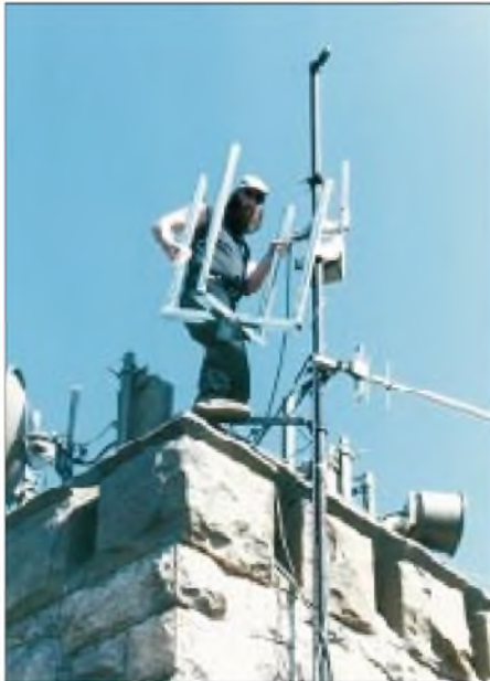
Jörg, DL3AKB, während der Antennenmontage bei DB0ILM auf der Hohen Warte
