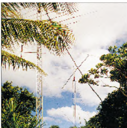
Das Setup von 3E1DX. Links der Mast mit der TH11DX und rechts der Mast mit der 4-Element-Antenne von KLM für 40 m
