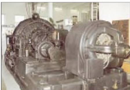
Der Maschinensender für Längstwelle besteht aus Motor (rechts), Getriebe (Mitte) und Generator (links).
