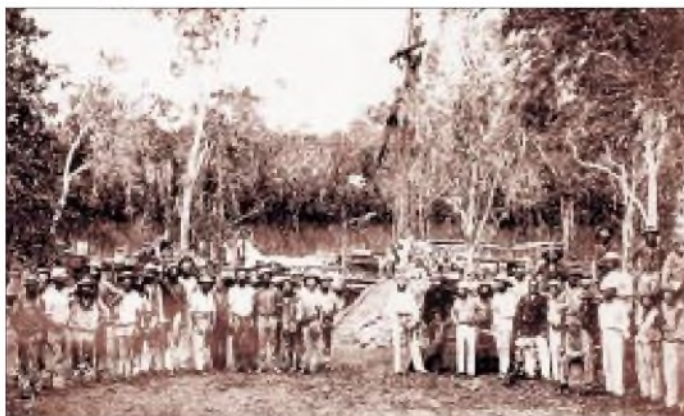
Ein Baurupp des Overland Telegraph in schwierigem Gelände
