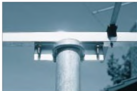
Bild 6: Selbstgebaute Halterung für Yagi-Antennen
