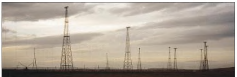
Vorhangantennen der PTT Ankara bei Emirler. Hier wird der Auslandsdienst der „Stimme der Türkei“ über fünf 500-kW-Sender ausgestrahlt. Foto: DG1EA, QSLs: via Michael Lindner
