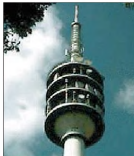
Der Standort von DB0BLN in der 33. Etage des Fernmeldeturms auf dem Schäferberg. Einige abgesetzte Linkstrecken sind zur HF-Entkopplung auch in der 28. Etage untergebracht und werden vom Digirechner via Kabel ferngesteuert.
