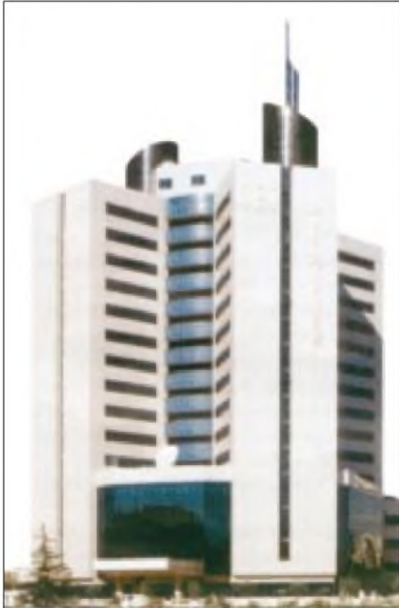
Das Gebäude von Radio China International
