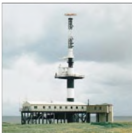
Radarstation Minsener Oog mit dem Quersmarkenfeuer „Bühne C“. Zum Schutz gegen Sturmfluten stehen die Betriebsgebäude zwei Stockwerke über dem Wasserspiegel.
