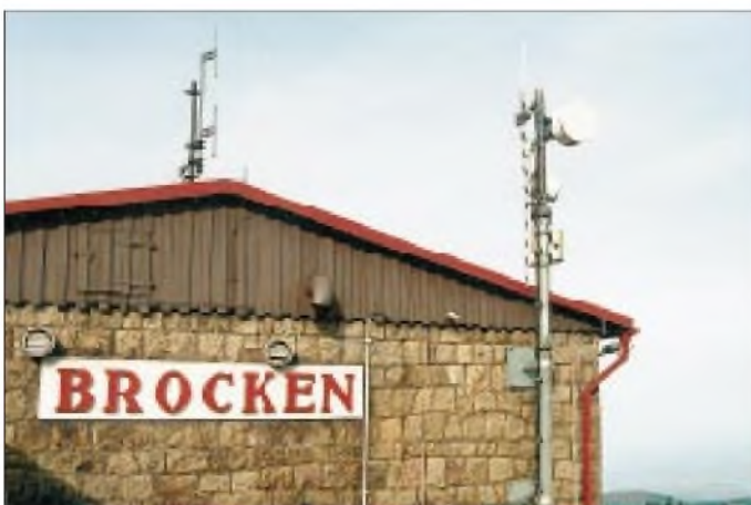
Das Bild zeigt den Brockenbahnhof. An der Spitze des rechten Mastes befindet sich die Rundstrahlantenne von DB0HSB.
