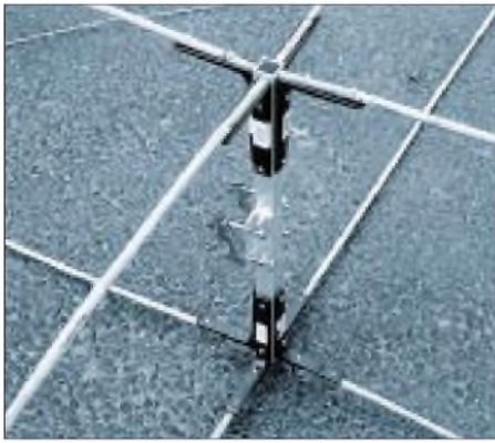
Bild 5: Befestigung der Spreizer mit Regalträgern
