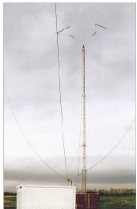
Bild 9: Container mit Abstimmereinrichtung; vom Speisepunkt (am Container rechts oben) zweigen drei Strahler ab, am oberen Mastende sind die Dachkapazitäten erkennbar.
