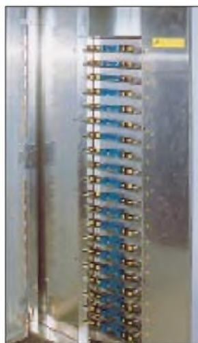
Bild 2: Netzteil des 100-kW-Transistorsenders; unten links die Gleichrichtereinheit, dahinter der Netztransformatoren, statt hoher Spannungen gibt es hier erhebliche Ströme.
