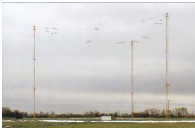
Bild 8: Die Dreieckflächenantenne ist an 50 m hohen Gittermasten befestigt.
