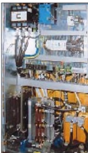
Bild 2: Netzteil des 100-kW-Transistorsenders; unten links die Gleichrichtereinheit, dahinter der Netztransformatoren, statt hoher Spannungen gibt es hier erhebliche Ströme.
