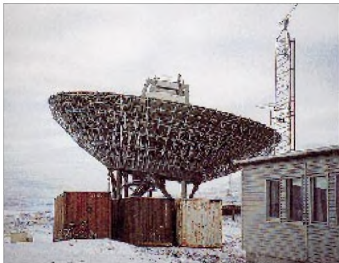
Svalbard-Radar: Die nicht schwenkbare 48-m-Parabolantenne. Zum Zeitpunkt unseres Besuches befand sie sich knapp vor der Inbetriebnahme.
