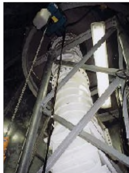
Im Turm der 48-m-Parabolantenne. Es dominiert der Wellenleiter, der die Energie zum Brennpunkt des Spiegels führt.
