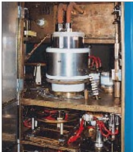
Die Senderöhre als Kernstück der einen 500-kW-Endstufe für Kurzwelle
