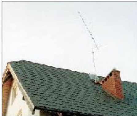
Das von Bernd (SO9AN) und Frank (SO9FB) am 27. und 28.5. in Jaroslaviec (JO84) „verschönerte“ Haus. Die 9-Ele.-F9FT wurde am Mobilmast durch eine geöffnete Dachluke installiert. Erfreulicherweise regnete es nur einmal, dafür heftig.
