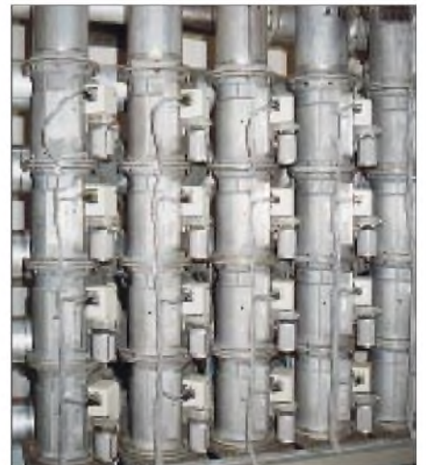
Diese Schaltmatrix stellt die Verbindungen von Sendern und Antennen her.
