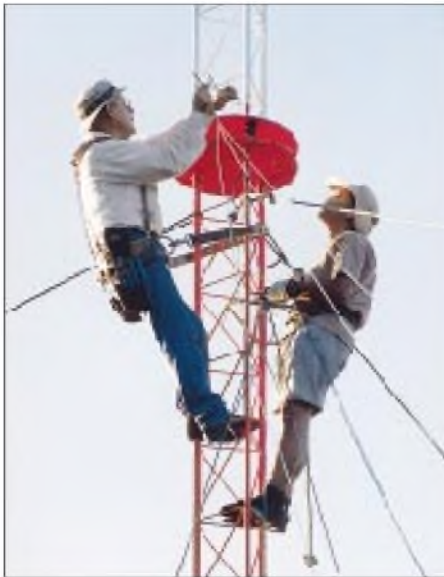
Winit, HS1CKC, und Milt, N5IA arbeiten an dem „elevated feedpoint“ eines 80-m-Foursquare-Sendemastes.
