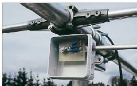
Bild 6: Neu gefertigte Anschlußdose mit Anpassungs-Kondensatoren und Halteplatte aus Epoxidharz-Material für das 12-m-Band
