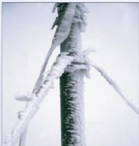
Der vereiste Mast am Sonntagmorgen: Antennenwechsel nicht möglich
