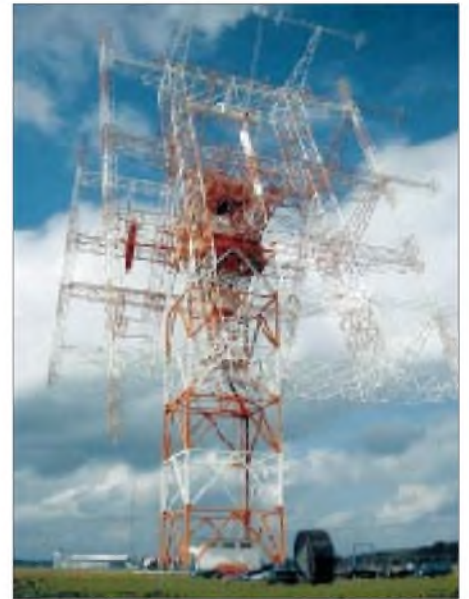
Drehstandantenne des KWZ 1
