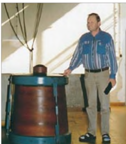
Ersatzfußisolator für den 154 m hohen Sendemast im Größenvergleich zum Autor
