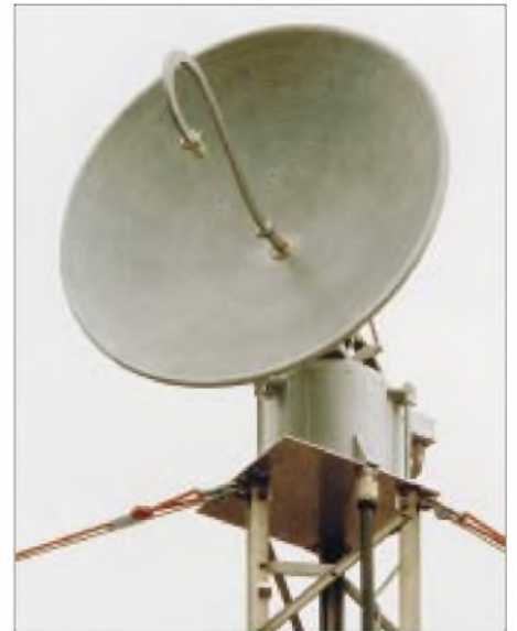
Ausschnitt aus der Antennenanlage von G3LQR im April 1995, rechts der 10-GHz-Spiegel mit sogenanntem Krückstockstrahler und direkt dahinter montiertem Transverter.
