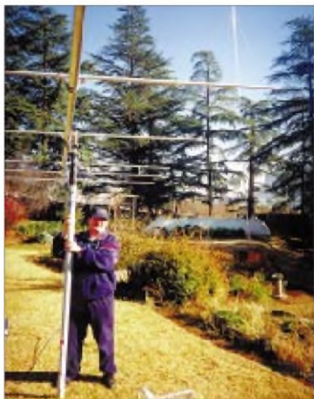
Thomas, DJ6OI, beim Aufbau einer 6-Ele.-ZX-Yagi am Standort von 7PBAA im Juli 2000. Trotz 1 kW und Skeds gelang kein QSO auf 6 m.
