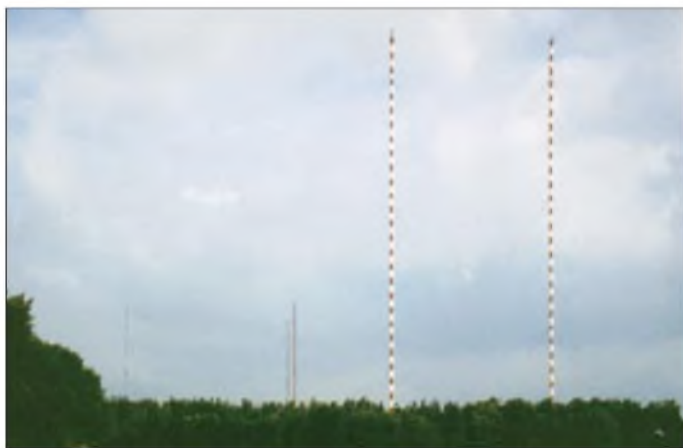
Sendetürme in Burg bei Magdeburg, damals gemeinsam vom Deutschen Freiheitssender und Deutschen Soldatensender genutzt. Von den beiden selbststrahlenden Rohrmasten rechts im Bild dient einer als Strahler, der andere als Reflektor.
