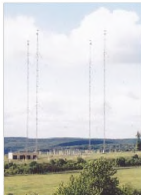
Die Quadratantenne besteht aus vier Gittermasten von je 125 m Höhe.
