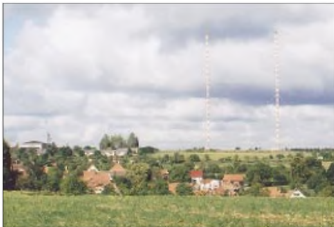
Blick zur Sendestelle Wachenbrunn. Im Bild die beiden 142 m hohen Rohrmasten aus den Jahren 1959 bzw. 1986, die eine Funktionseinheit bilden.
