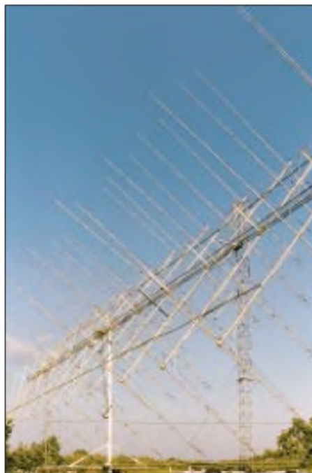
Bild 3: Die wohl bisher größte Amateur-Antennenanlage, bestehend aus 48 Yagis mit je 17 Elementen, bei W5UN in Texas
