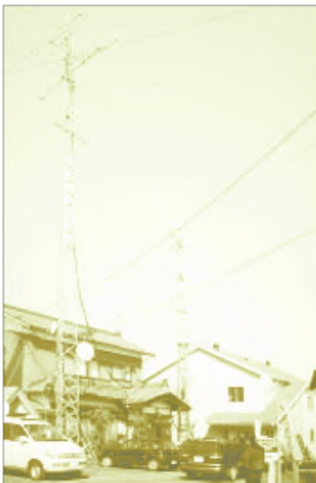
Bild 15: Antennenanlage von JA0BLU - in Japan stehen die Antennen bisweilen auf der Straße ... Fotos: via DL2RSX
