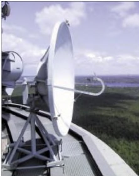
Der 2-m-Spiegel auf dem Berliner Funkturm für den Link von DB0BLN nach DB0LUC. Fotos: DC7GB
