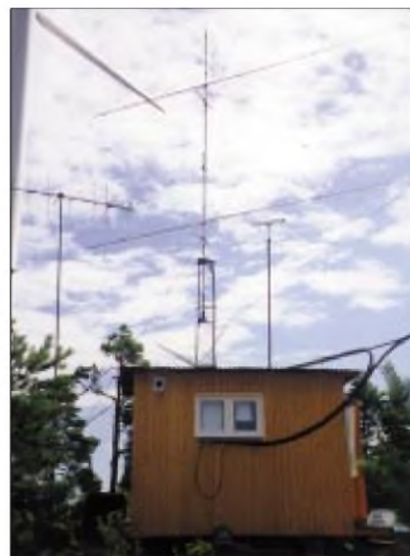
Am Standort von OH0N in KP00AB: Die Antennenanlage von OH0JFP/p.
