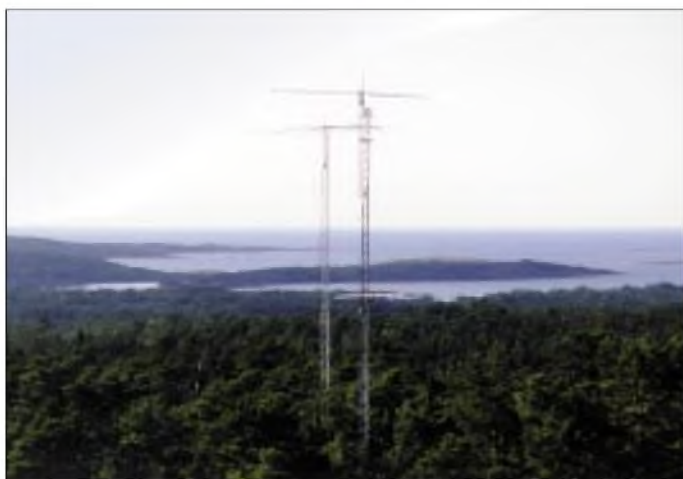
Das Take-off in Richtung USA; vorn die 2 x 5-El.-10-m-Beams, dahinter der TH7DXX in 22 m Höhe.
