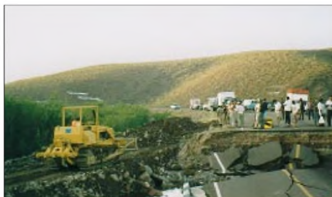
Erste Maßnahme: Zur Überbrückung der eingestürzten Straße wird eine Rampe zusammengeschoben.
