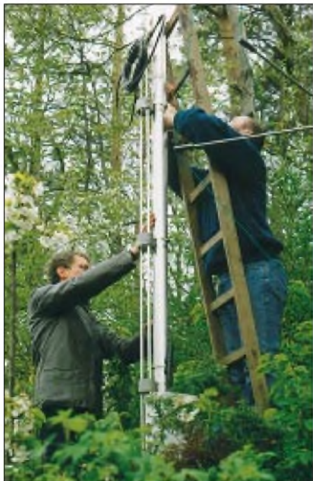
Bild 6: DK8ND und SWL Rainer bei der Montage; Haarnadelschleife und Verlängerungsspule sind deutlich erkennbar.
