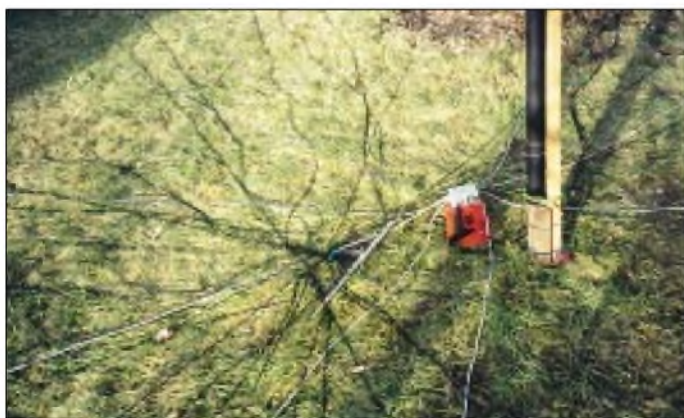
Bild 4: Fußpunkt einer Groundplaneantenne mit auf dem (winterlichen) Rasen aufliegenden Radialnetz. Die Berechnung der erforderlichen Anpassung ist mit dem Smith-Diagramm schnell bewerkstelligt.
