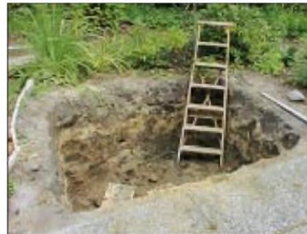
**Bild 2:** Den Ausgangspunkt bildet das Ausschachten der Grube – 4 m<sup>3</sup> Erdrreich!
