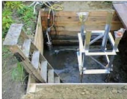
**Bild 4:** Der ausgerichtete und verankerte Mastfuß
