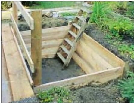
**Bild 3:** Schalbretter verhindern das Einstürzen der Grubenwände.
