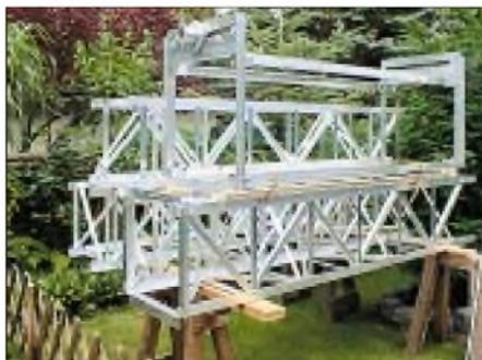
**Bild 6:** Der Zusammenbau der Mastsegmente erfolgt gemäß Herstellervideo.
