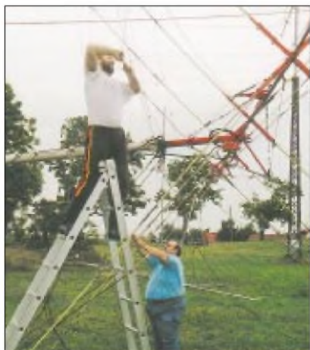
Bild 11: Ist die Antenne erst einmal unten, können alle Punkte mit Hilfe einer einfachen Leiter vom Boden aus erreicht werden. Ben, DL5ANT, und Uwe, DL5AOJ, HF-Referent von Thüringen, beim Anfertigen von 96 Knoten zur Elementbefestigung.
