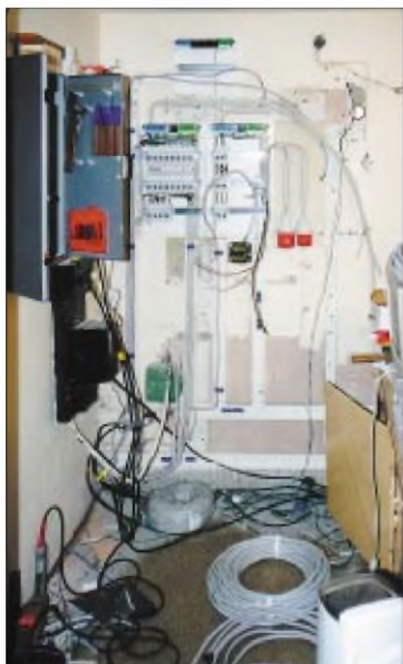
Bild 3: Wenn es im Shack schon keinen dicken Strom gibt, können auch die Kabel erneuert werden. Kupfer anstelle Alu war die erste Parole und die zweite besagte, ein paar Drähte mehr dürfen es auch sein. So entsteht die neue Kraftzentrale.
