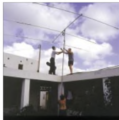
Abbau der Antennen am 14.3.
