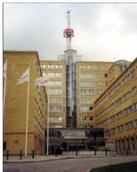
Das Telia-Haus in Stockholm Nacka Strand. Im obersten Stockwerk arbeiten die Funker von „Stockholm Radio“
