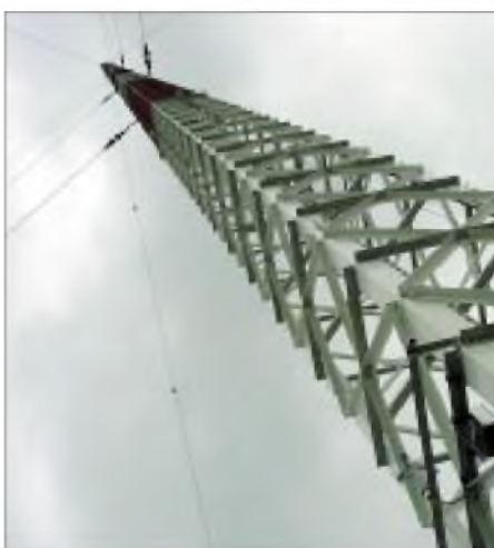
Eine der 360 m hohen Sendeantennen in Donebach
