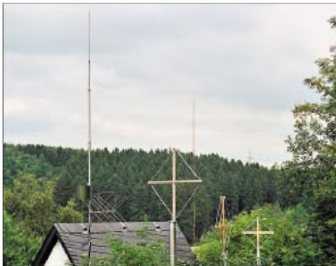
Bild 1: Ein Teil der Sferics-antennenanlage von DG9WF; zwischen den Rahmenantennen erkennt man die Stabantenne zum Empfang der vertikalen Feldkomponente.
