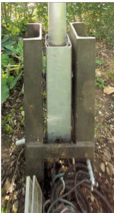
Bild 5: Diese Frontansicht des Mastfußes läßt zugleich den Anschluß der Radials erkennen. Fotos: DL3MCO
