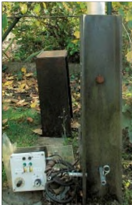
Bild 3: Seitenansicht des Mastfußes; rechts unten ist der Befestigungsbolzen mit Sicherungssplint zu sehen.
