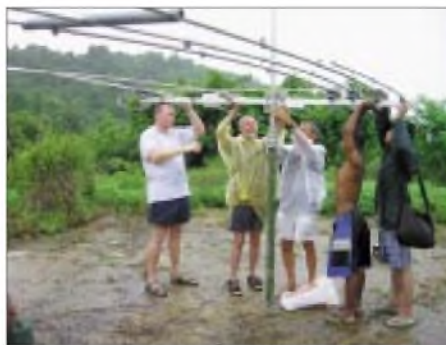
Die Sommer-Yagi XP-406 am Schiebemast
