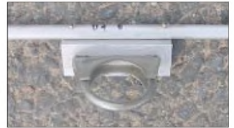
Bild 10: Haltewinkel mit Auspuffschelle für Tragrohre aus Rundmaterial
