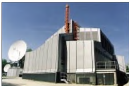
Die links sichtbare Antenne ist die ehemalige Telekom-Antenne Nr. 3. Das Gebäude im Vordergrund ist das damalige Telekom-Betriebsgebäude.
