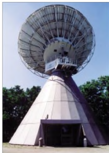
Die ehemalige Telekom-Antenne Nr. 4. Jetzt von der KB Impuls Service GmbH genutzt.
