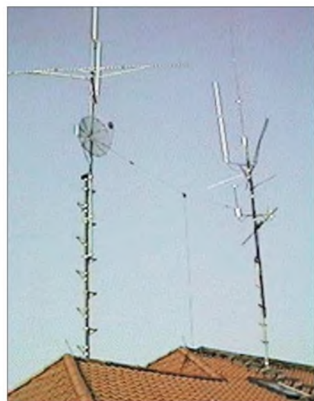
DB0GV: 23-cm-Antennen zu DB0BOS und DB0ASF
