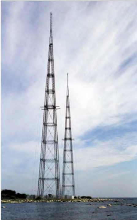
Antennentürme des Senders Sölvesborg
