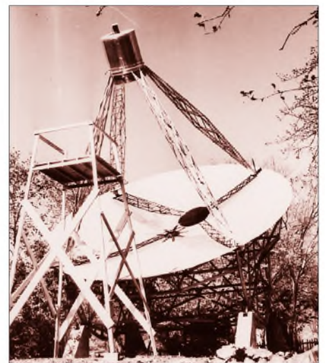
Das erste Radioteleskop der Welt, 1938, erbaut von Grote Reber im elterlichen Garten in Wheaton, Illinois Foto: NRAO
