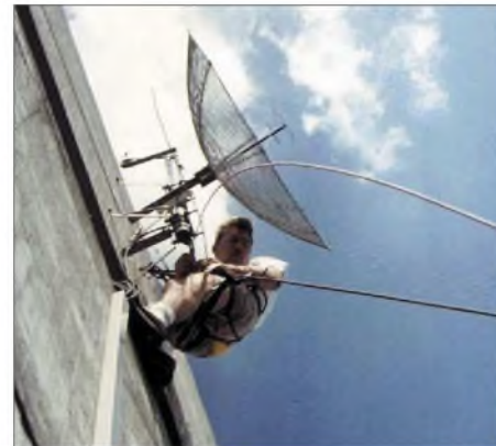
Antennenarbeiten beim Flexnet-DAMA-Digipeater DB0DAR (438,125 MHz Simplex, 1k2/9k6) der AG der Funkamateure an der TH-Darmstadt
