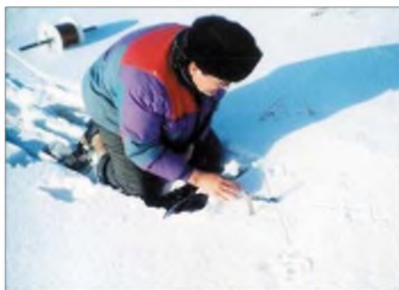
UA9OC prüft mit Hilfe eines „Sonnenkompasses“ die richtige Richtung der Beverage für den Neuseeland-Versuch.
