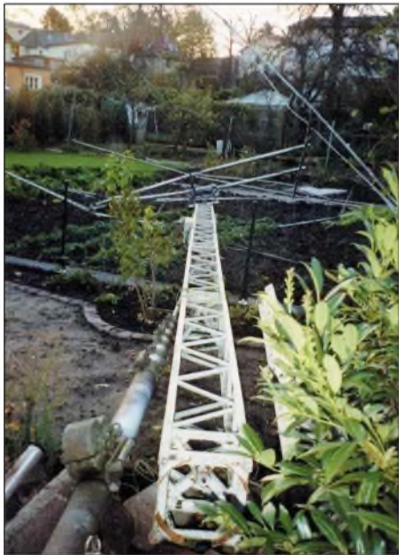
So sieht es aus, wenn einer EME-Station mit 4 x 17-Ele.-Yagis von M 2 der Gittermast vom Orkan geknickt wird: Jo, DL9MS (JO54), staunte nicht schlecht, als seine 2-m-Antennenanlage in Nachbars Garten lag – natürlich total demoliert!
