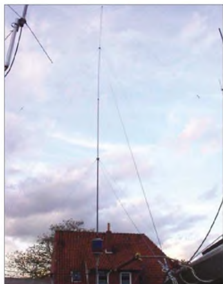
18 m hohe „Umbrella“-Antenne von DK8KW
