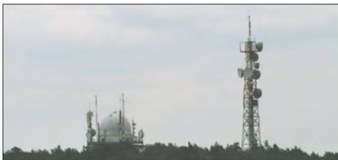
Gesamtansicht der Sendeanlagen auf den Müggelbergen. Links der unvollendete Fernsehturm und rechts ein Stahlgittermast für den Richtfunk. Von diesem Turm wurde von 1953 bis 1958 das Programm des DDR-Fernsehens abgestrahlt.
