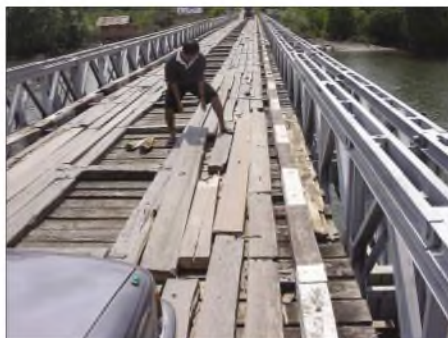
Kleinere Reparaturen in Eigenregie sind Alltags bei Brückenbenutzungen.
