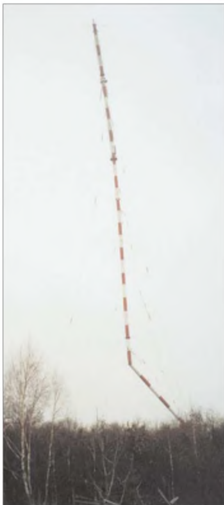
Am 19. Dezember 2002 wurde der Sendemast des Mittelwellensenders in Berlin-Köpenick gesprengt. Die verwendete Sendefrequenz von 693 kHz nutzt derzeit Megaradio vom Standort Zehlendorf aus.
