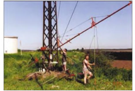
Ben, DL5ANT, und Steffen, DL4ALB, bei der Montage der 24 Glasfaserstäbe für die auf einem 15 m langen Boom aufzubauende 6-Ele.-Quad für 15 m.
