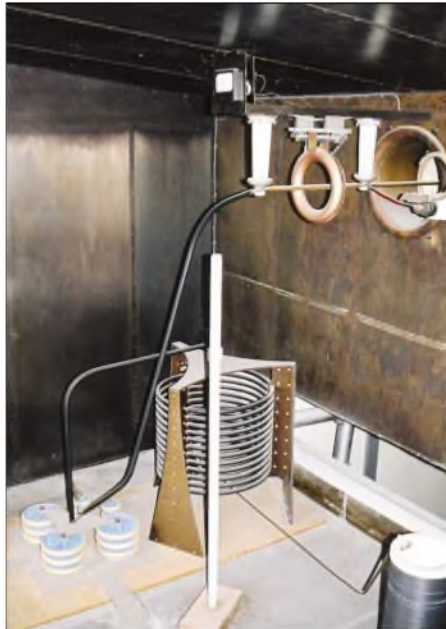
Transformation von 50 Ω auf 220 Ω vom Koaxialkabel zur Speiseleitung der Langwellenantenne; die Leuchtstoffröhre im Vordergrund wird als HF-Indikator benutzt
