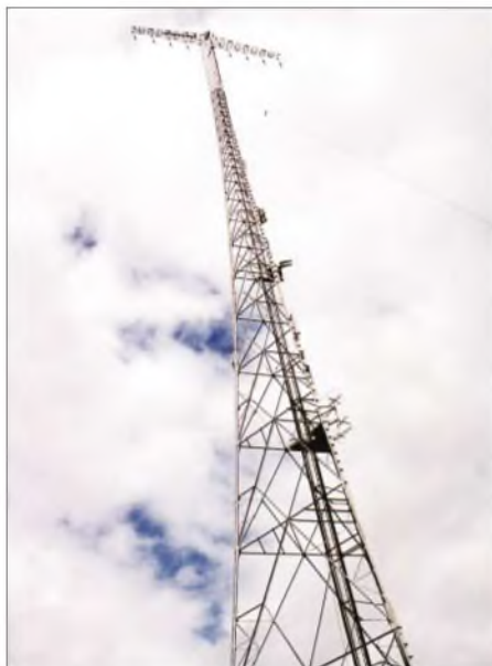
Direkt gespeister Langwellen-Antennenmast nahe des Stationsgebäudes
