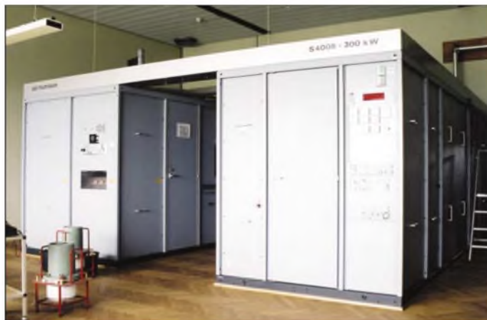
300-kW-Langwellensender; links die Modulatorstufe, rechts Steuer- und HF-Stufen; vorn links ausgetauschte Senderöhren
