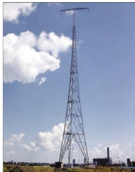
Passiv gespeister Antennenmast der Langwellenantenne
