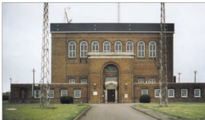
Bild 1: Rugby Radios Antennenfarm umfasst über 400 Exemplare aller Arten.
