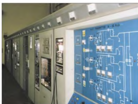
Bild 6: Die drei 16-kHz-VLF-Sender besitzen heute ein modernes Outfit und eine Luftkühlung. Fotos: G. Schenz
