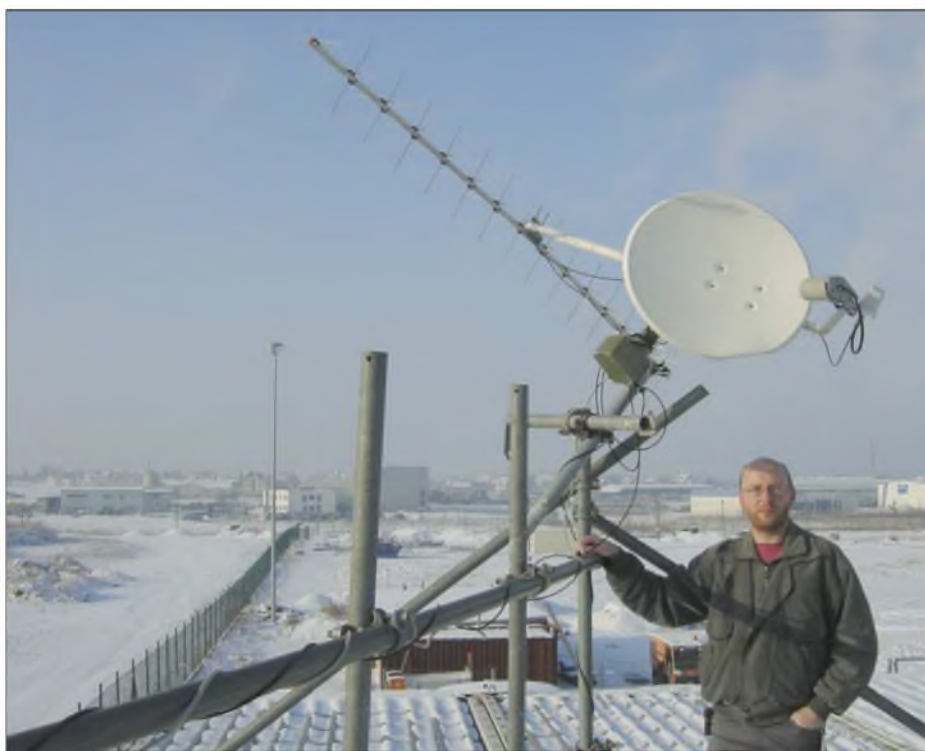
Bild 3: Detailaufnahme der auf Rüststangen und Kreuzschellen basierenden Antennenkonstruktion im winterlichen Dresden; rechts im Bild der Autor. Fotos: DL1DUZ
