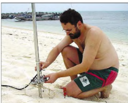
Falk, DK7YY, beim Aufbau der Butternut-Antenne HF6V, etwa 10 m entfernt vom Meer
