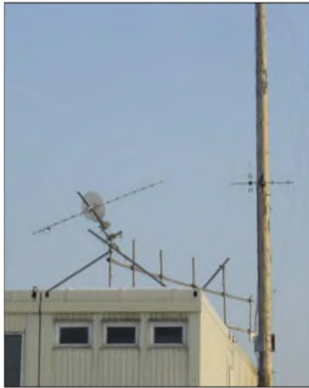
Bild 1: AO-40-Antennenanlage von DL0AMD (ganz links), aufgesetzt auf eine recht massive Plattform aus Rüststangen
