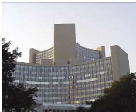
Das 148 m hohe Gebäude der IAEA (International Atomic Energy Agency) in Wien
