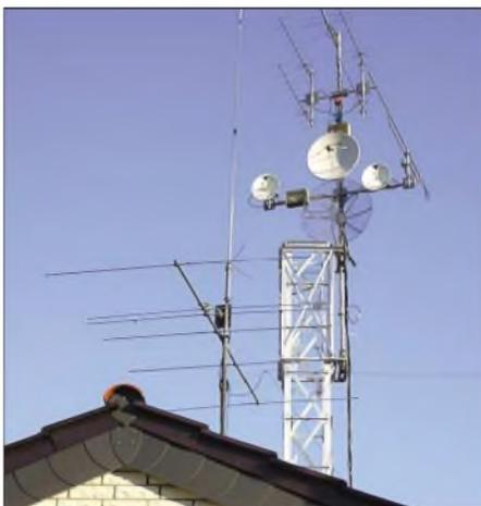
Die komplette Antennenanlage von 6 m bis 24 GHz
