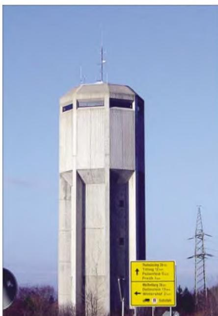
Der Wasserturm mit 45 m Höhe als idealer Standort für UHF. Links die Antenne von DB0EIC (439,175 MHz in JN580V). Bei klarem Wetter sieht man bis zum Alpenhauptkamm. Fotos: DL3MGK
