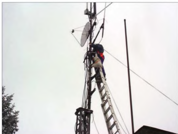
Erste Demontagearbeiten (Antennenanlage) bei DB0QT am 6.3.04. Das betrifft die Links zu DB0WST (Birk/Lohmar), DB0ZDF (Mainz) und DB0LJ (Kruft)
