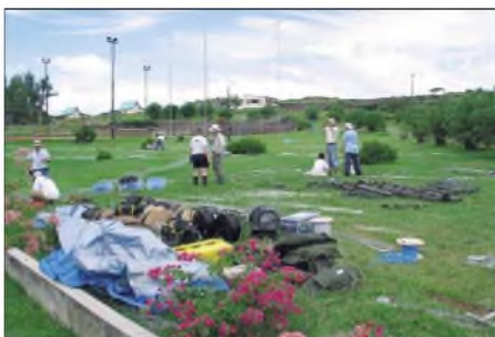
Das Gelände der zukünftigen Antennenfarm, im Vordergrund ein Teil des mitgenommenen Koaxialkabels
