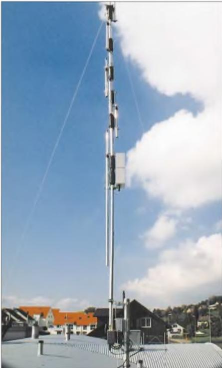
**Bild 1:** Betriebsbereite Antenne auf dem Dach aus Wellblechbahnen; etwa in der Mitte ist das wetterfeste Gehäuse zu erkennen, das Drehkondensator und Motor aufnimmt.
