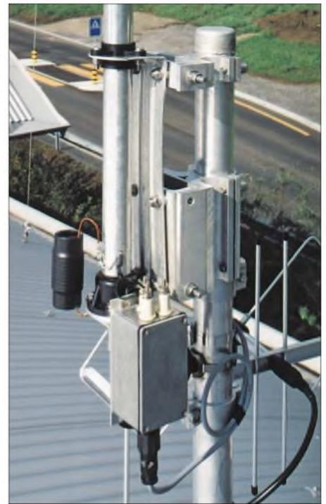
**Bild 6: Bei diesem Kippmechanismus bleibt die Antennenbasis drehbar mit dem Mastrohr verbunden.**
