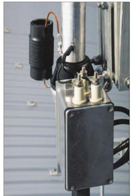
**Bild 3:** Das im unteren Bildteil erkennbare Aluminiumgehäuse beinhaltet die Abblockung für die drei Leiter des Steuerkabels.
