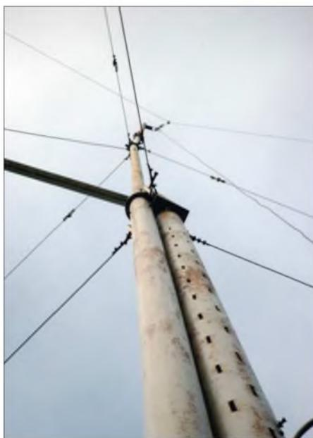
**Bild 3:** Schaden am Mast der 4-El.-40-m-Yagi
