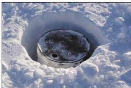
Leere Dieselfässer dienen als Ankerpunkte für die Abspannung der Antennen.
