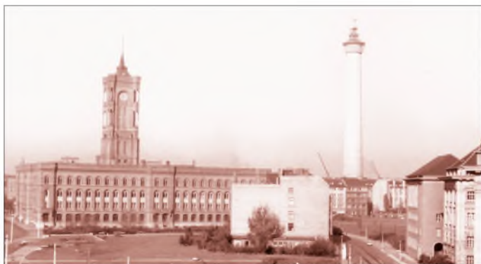
Der Turmschaft des Berliner Fernsehturms erreichte am 4.10.1966 bereits die 100-m-Marke.
