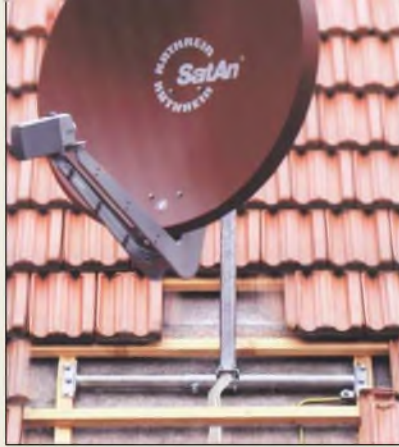
Die Koaxialkabel lassen sich durch den Dachsparrenhalter führen.
