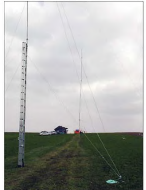
Die Antenne des OV P 41 aus dem vergangenen Jahr. Dieses Jahr wurde sie noch verbessert und mit 15 Top-Load Radials versehen. Fotos: P 41
