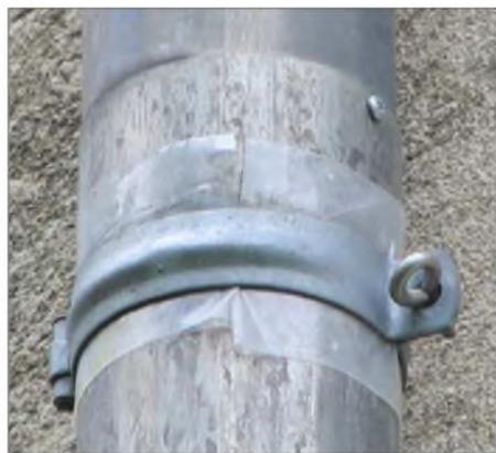
**Bild 2: Isolierung des Fallrohrs vom Mauerwerk und Schraube zur Verbesserung des Kontakts zwischen den Rohrsegmenten**
