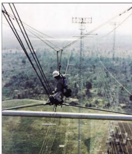
Blick auf die Antennenlandschaft der VoA-Relaisstation in Udorn (Thailand). Von hier werden Programme in Richtung Asien und Australien ausgestrahlt. Die sieben Sender haben eine Leistung von je 500 kW.
