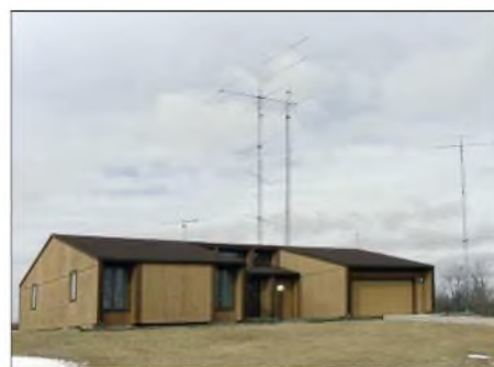
K8CC: Antennen mit Haus – Zwei der vier KW-Maste sind zu sehen; rechts UKW-Mast
