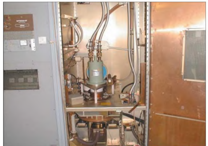
Im Innern eines der Sender sind gut die wassergekühlte 100-kW-Endstufenröhre und die massive HF-Metallabschirmung der Tür zu erkennen.
