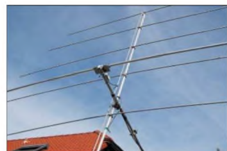
Bild 2: Montage des Rotary-Dipols oberhalb der LP7, Mast gekippt Fotos: DL7VEE
