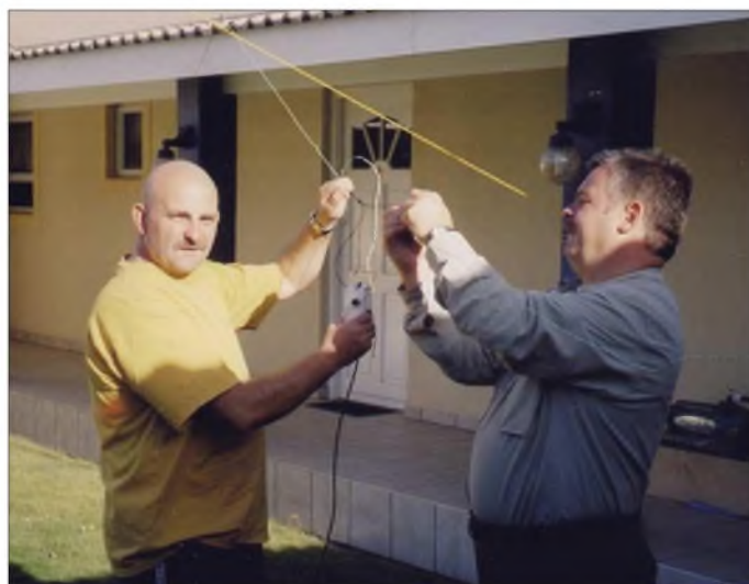
Jörg, V5/DL3NRV, und Jürgen, V5/DL7UVO, beim Aufbau der Quadschleife für das 17-m-Band
