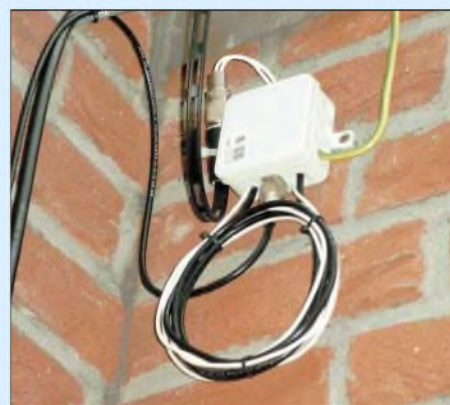
Bild 15: Hier ist der Symmetrierübertrager zum Übergang auf ein – möglichst kurzes – Koaxialkabel unmittelbar nach Einführung der Hühnerleiter in das Haus angeordnet.
