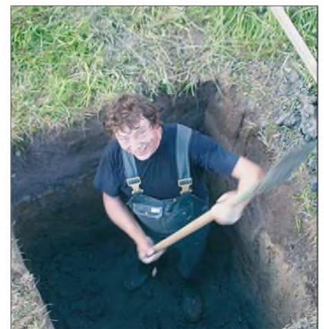
Bild 3: Der Aufwand für eine hinreichend große Fundamentgrube ist nicht zu unterschätzen ...
